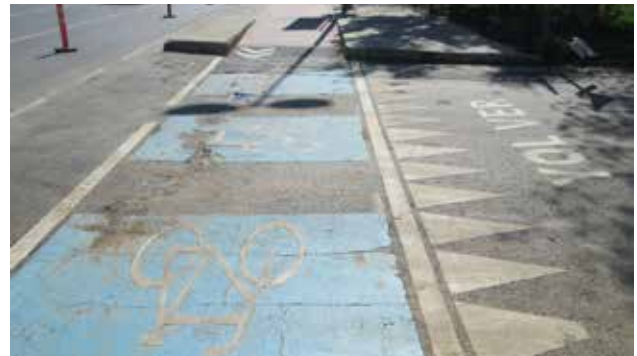
Şekil 132: Bisiklet yolu üzerindeki deformasyonlar
