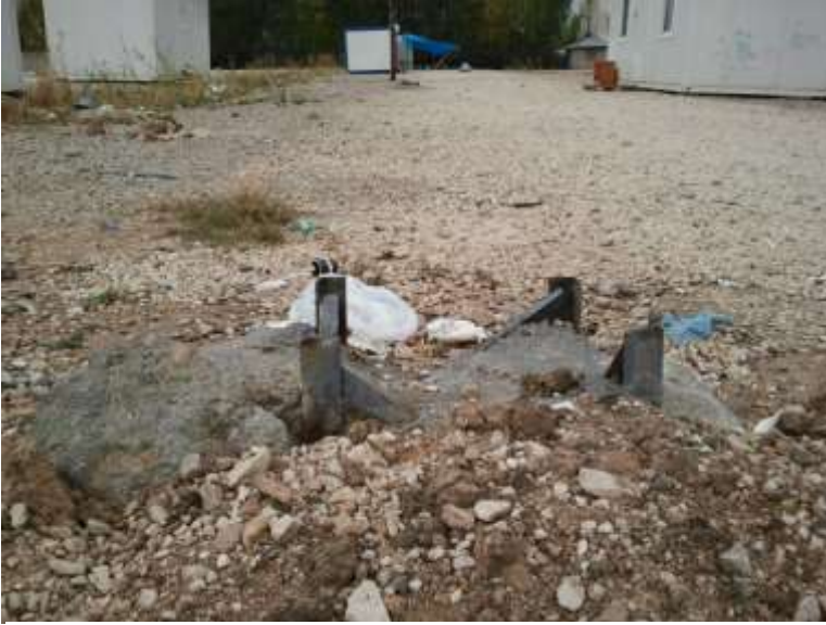
Fotoğraf 22 Konteynır kente kesilmiş bir elektrik direği
