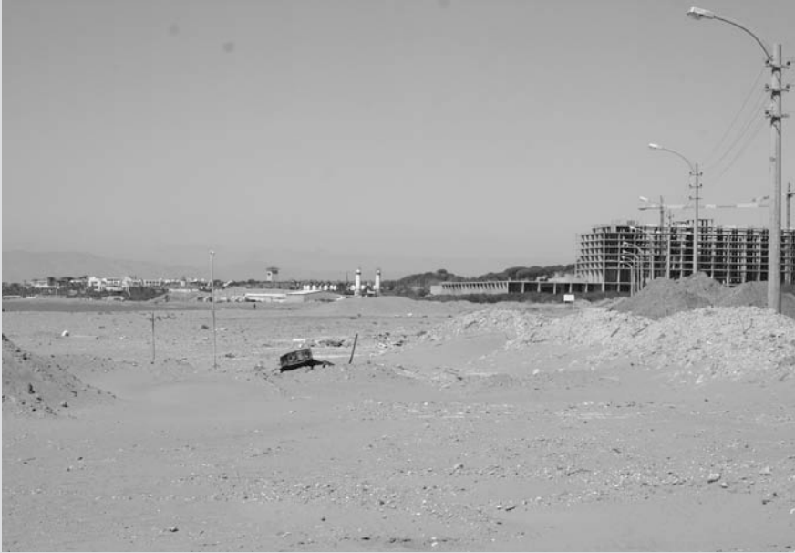
Belek Kumulları, caretta caretta üreme alanları ve inşaatlar
