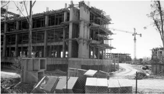
Belek'te devam eden otel inşaatları
